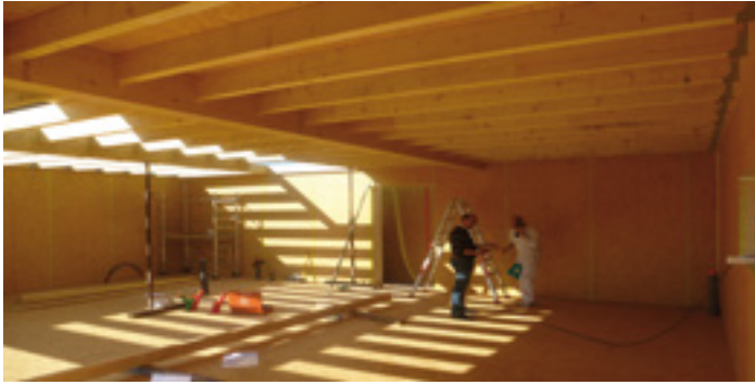
Mise en œuvre de la toiture
