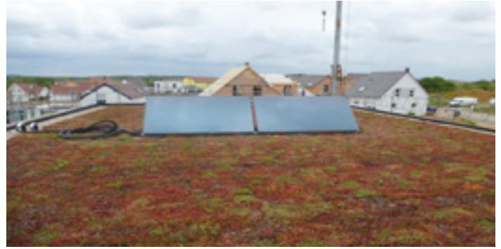
Vue sur la toiture végétalisée
