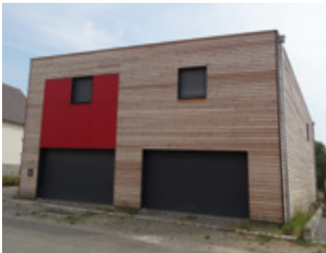
Façade Nord du plancher du 1 er étage
