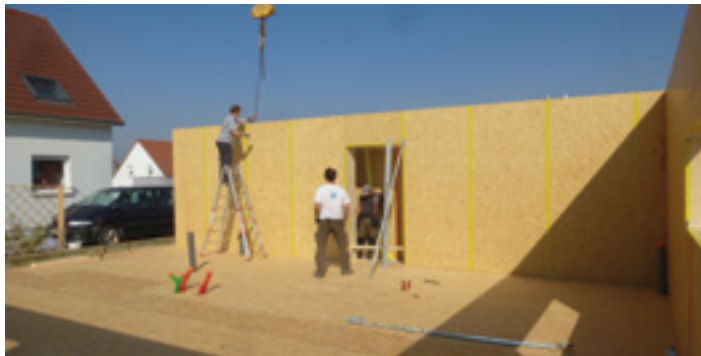
Pose de cloisons intérieures
