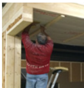
Fermeture des trous d'insufflation avec des scotchs d'étanchéité à l'air
