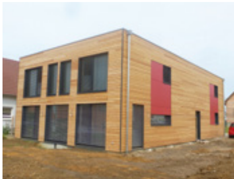
Vue sur les façades Sud et Est
