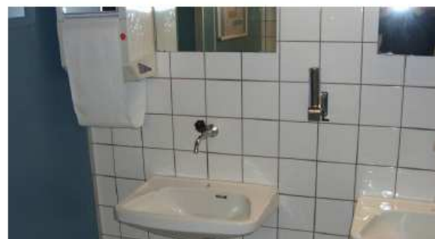
Vérification et si besoin modification des débits
